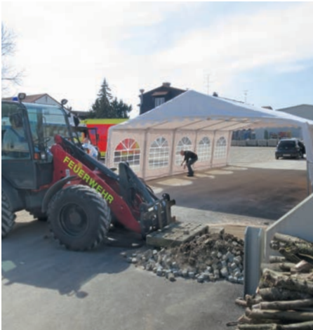
Aufbau der Corona-Teststation Hasenheide.
