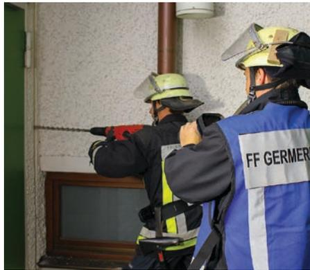
Bohrung für Einsatz der Löschschlanzen.
